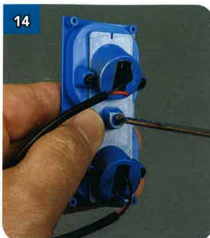
14 ... e fissalo con una vite flangiata da 2x6 mm.
